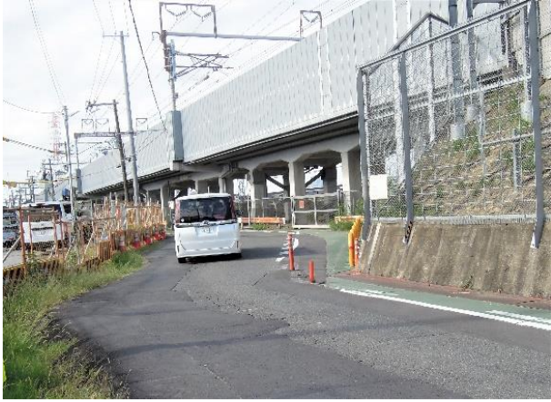
クランク部（幅が狭い箇所）
